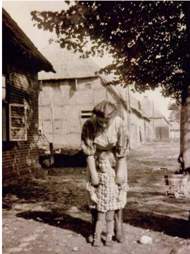
Wirtschaftsgebäude Holdorf (Archiv Fünf Türme e.V.)
